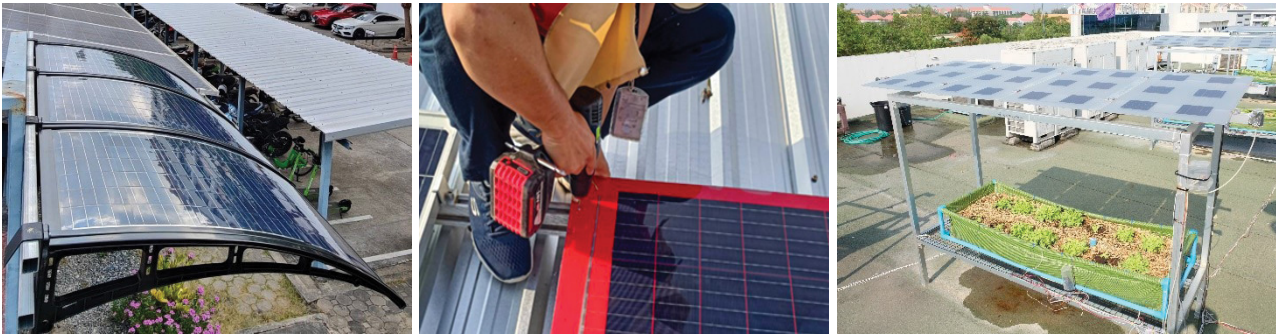
รูปที่ 3.3 การพัฒนาแผงเซลล์แสงอาทิตย์น้ำหนักรเบา และแผงแบบโปร่งแสงที่แสงในช่วง PAR ที่เหมาะสมกับการเจริญเติบโตของพืช สามารถส่องผ่านได้เพื่อนำมาใช้งานในรูปแบบของ Agrivoltaic
