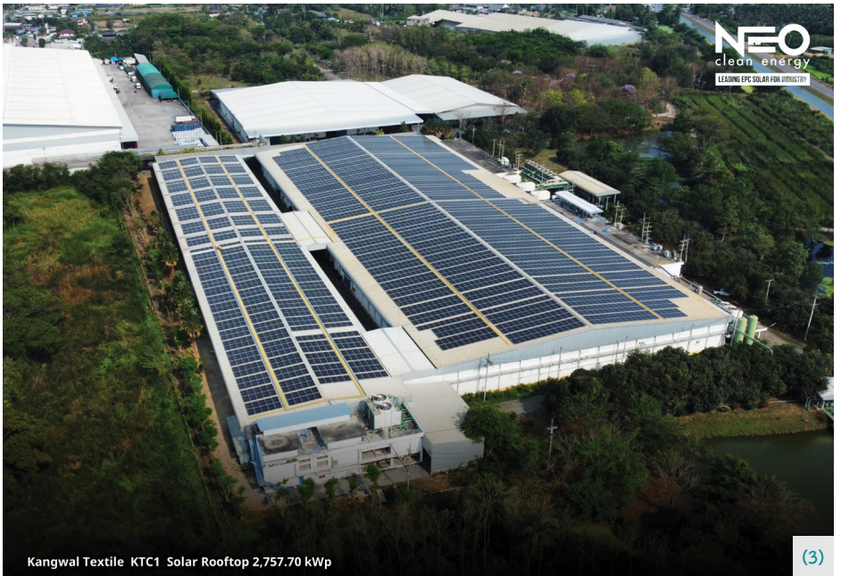
(3) ระบบที่ติดตั้งบนหลังคาขนาด 2.7 MWp ที่ อ.โพธาราม จ. ราชบุรี
