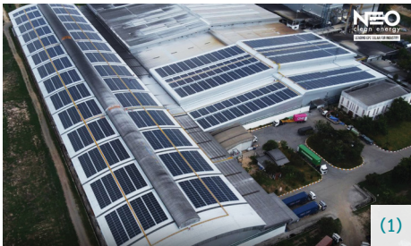
(1) ระบบที่ติดตั้งบนหลังคาขนาด 2.0 MWp ที่ อ.บ้านบึง จ. ชลบุรี
