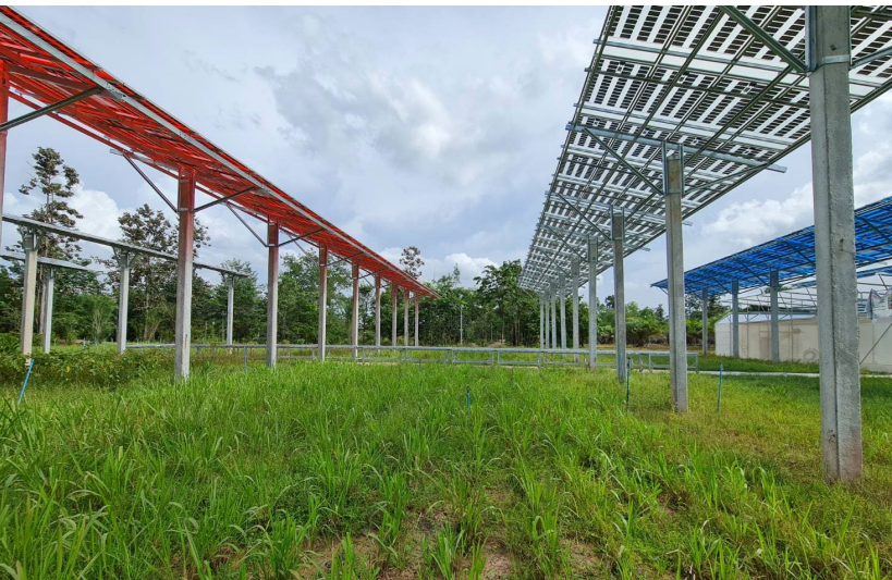
รูปที่ 2.12 ตัวอย่างระบบผลิตไฟฟ้าพลังงานแสงอาทิตย์แบบไม่เชื่อมต่อกับระบบโครงข่ายไฟฟ้า (Off-grid) ในรูปแบบระบบไมโครกริด ขนาดกำลังการผลิตติดตั้ง 28 kWp ร่วมกับระบบกักเก็บพลังงาน (BESS) 21.3 kWh ผสมผสานกับการเพาะปลูกที่ จ.อุบลราชธานี ซึ่งดำเนินการโดย สวทช.
