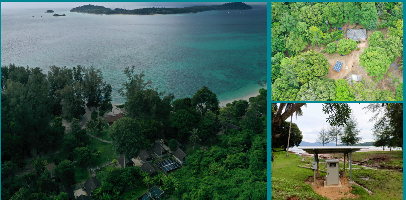
รูปที่ 5.9 ระบบผลิตไฟฟ้าพลังงานแสงอาทิตย์บนเกาะตะรุเตา จ.สตูล
