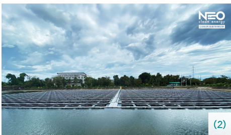
(2) ระบบที่ติดตั้งบนทุ่นลอยน้ำขนาด 806 kWp ที่ อ. เขาย้อย จ. เพชรบุรี
